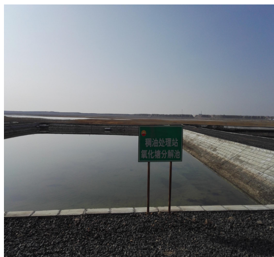
厂内整体情况
